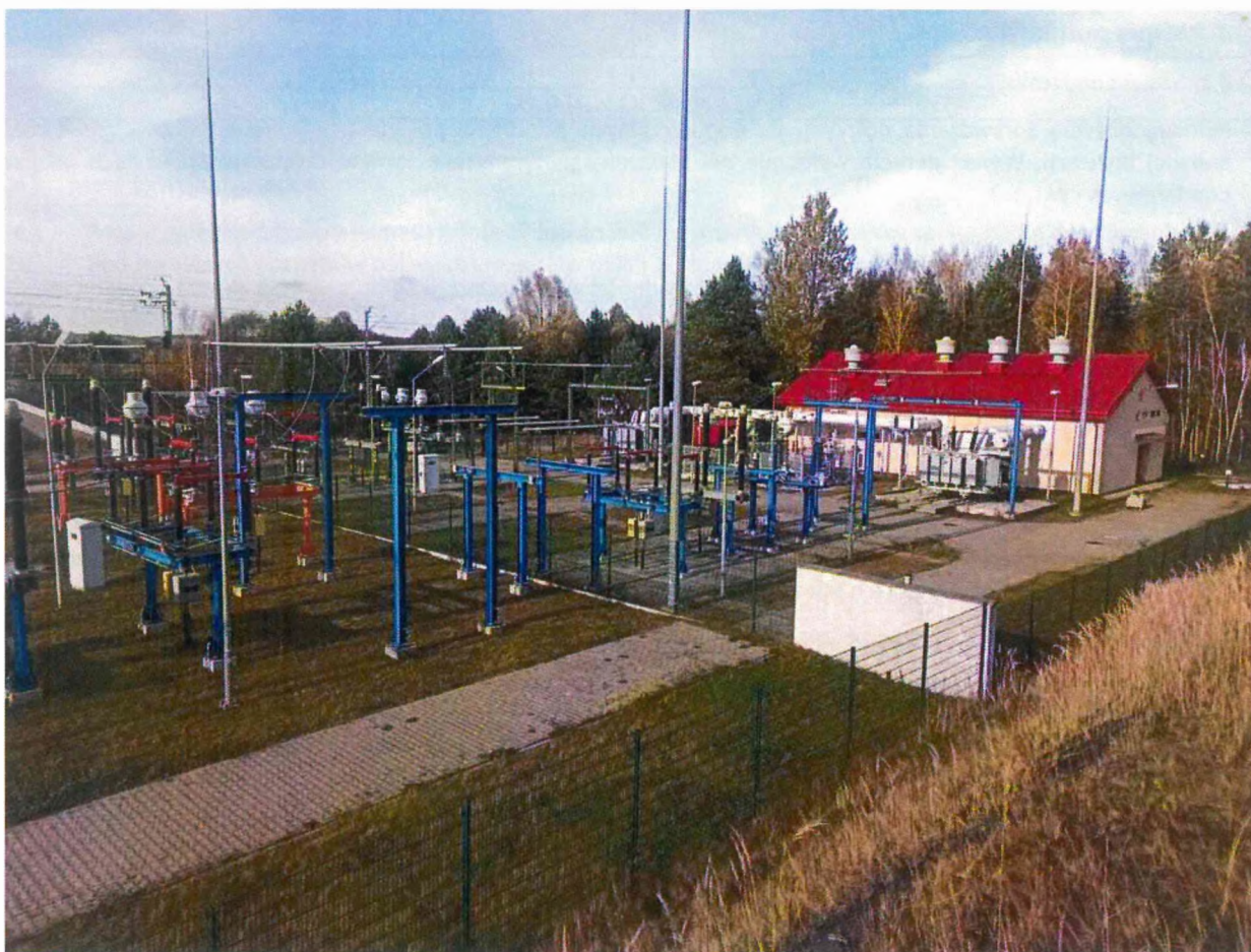
Zdjęcie 1 Badany obiekt
